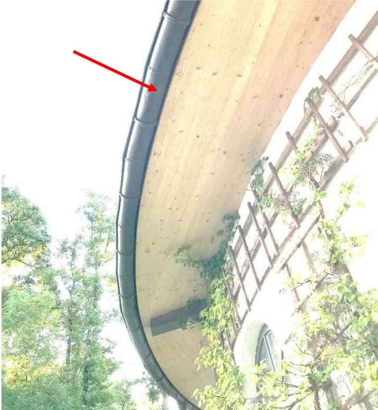
Abbildung 17: Potentielle Einflugmöglichkeit für Fledermäuse in den Zwischendachbereich hinter der Dachrinne (roter Pfeil).
