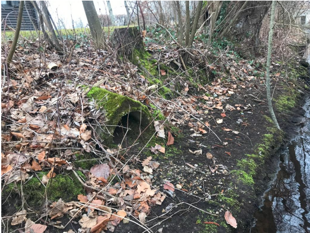
Abbildung 9: Bestehendes Rohr in den Lienzinger Bach für frühere Entwässerung.
