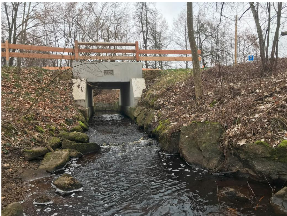
Abbildung 10: Lienzinger Bach mit neuer Brücke (28.02.2024).
